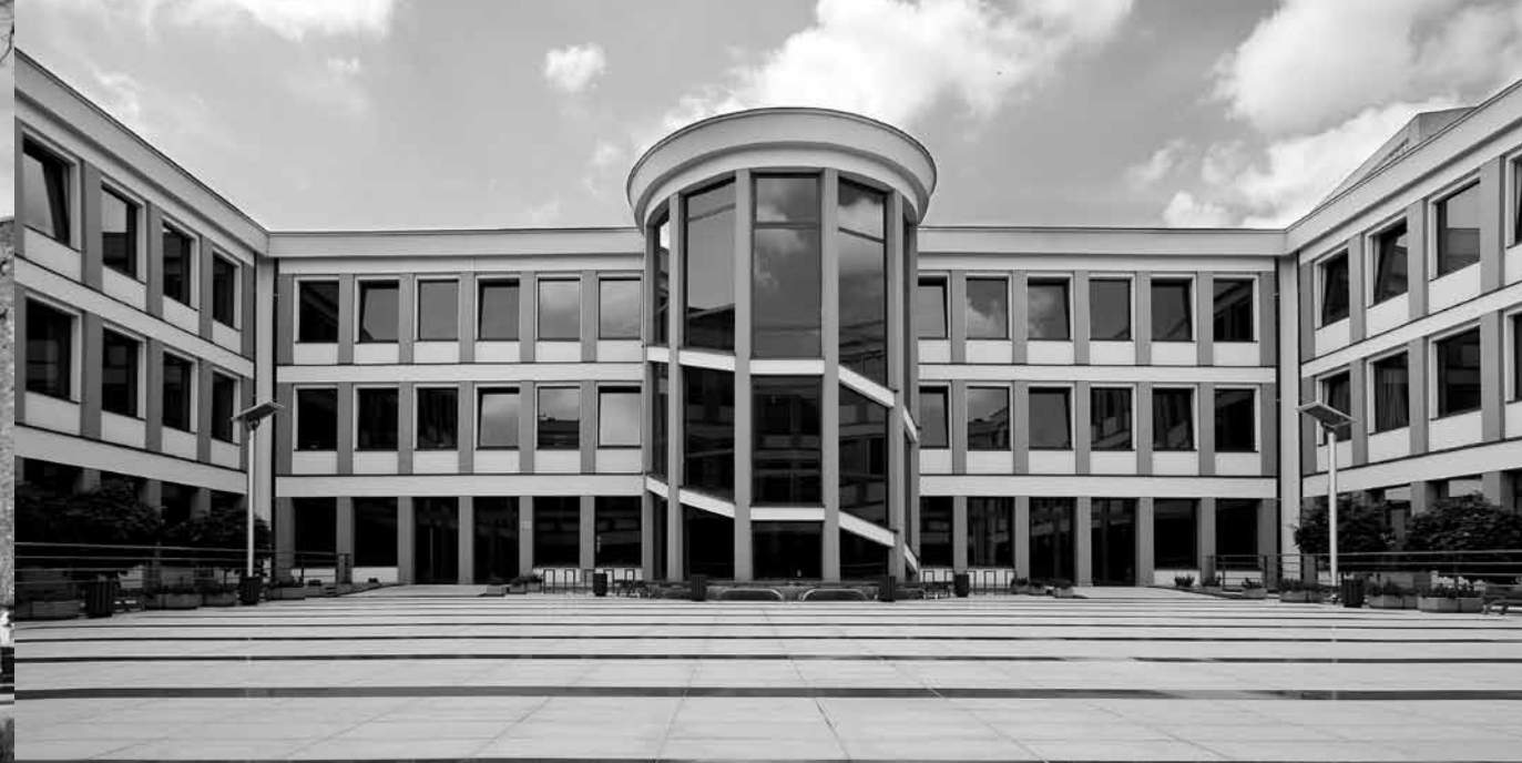
GMACH PRZY UL. OKÓLNIK 2 BUILDING AT 2 OKÓLNIK ST.
